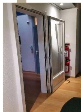
En installant un nouvel ascenseur, de nouvelles normes «sécurité incendie» devaient être appliquées. La pose d'une alarme incendie adaptée ainsi que des portes coupe-feu sur les trois étages du foyer ont été posées.
