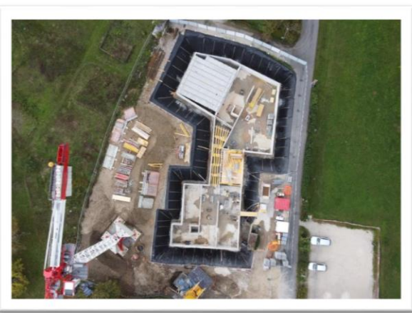
Les travaux de notre site principal d'Ecogia, à Versoix
